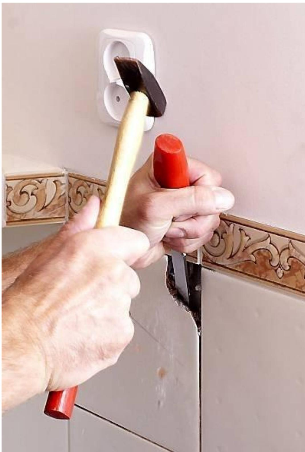
Вдоль швов и зубцами по всей поверхности с помощью этих инструментов
